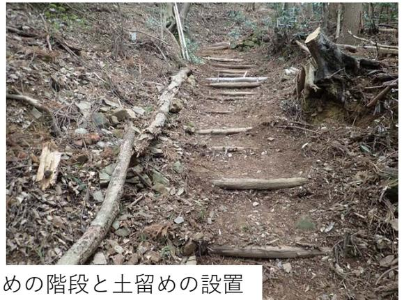
雨水による洗堀防止のための階段と土留めの設置
