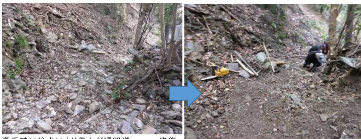
豪雨時に谷水により傷んだ遍路道 修復
