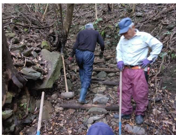
山中の倒木芯材による階段の修復作業
