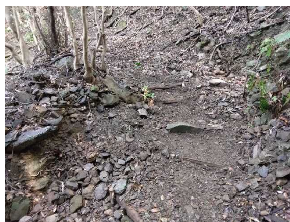
修復された遍路道
