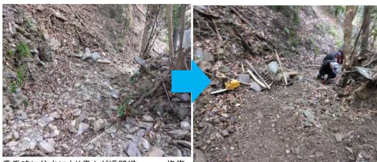
豪雨時に谷水により傷んだ遍路道
